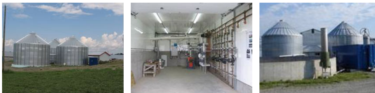
Figure 2. Biodigesteurs, système de contrôle et torchère
