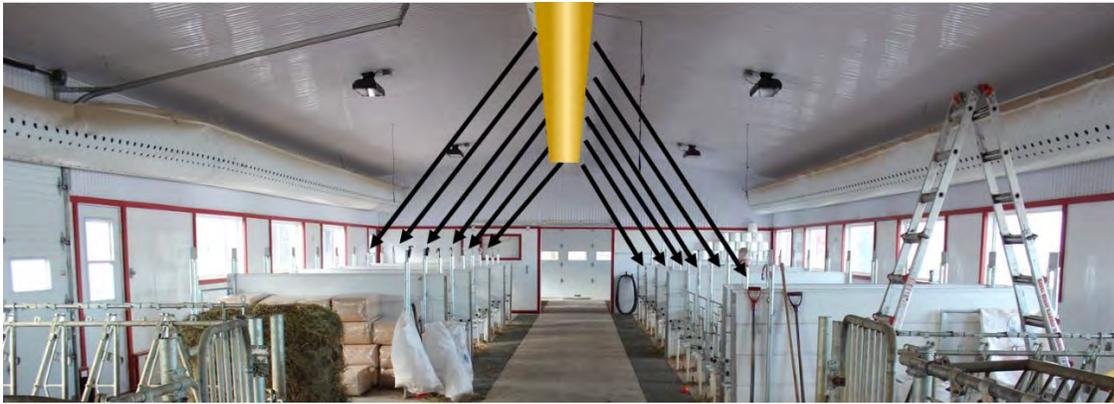
Figure 8. Schématisation d'une ventilation à gaine de diffusion d'air sous pression positive. Photo : S. Adam.
